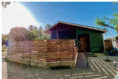
「tetote」新築住宅の施工例
