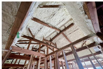
古民家の「tetote」リノベーション工事
