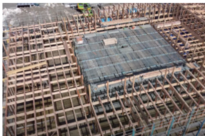
木造工場・事務所新築工事（空撮）
