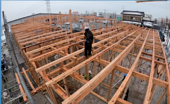
木造工場・事務所新築工事
