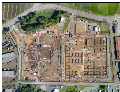
「岩手県の現場写真（この現場でGLOBEConstructからICT建機連携を実施）」
