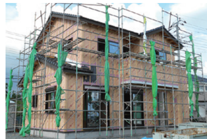
断熱施工が進む現場
