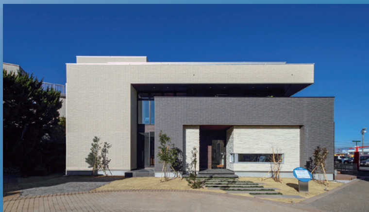
施工例：モデルハウス「ネクストハウス立川」(外観)
