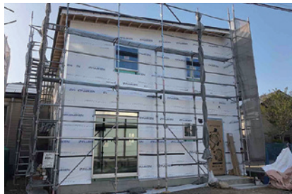
施工現場の様様
