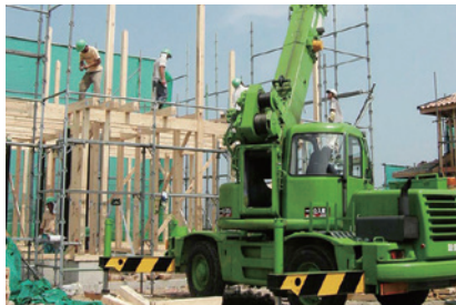
自社保有の重機による建前
