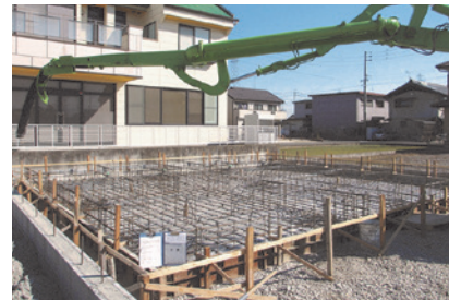
打設 & 配筋工事
