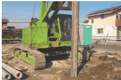
自社保有の重機による地盤補強
