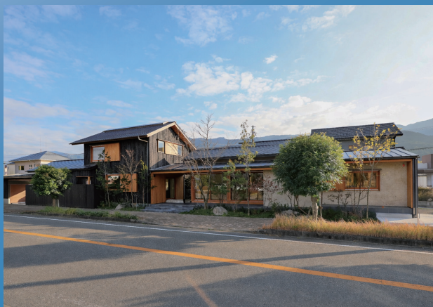
施工例(糸島モデル 外観)
