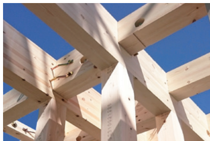
施工現場の様子(上棟)
