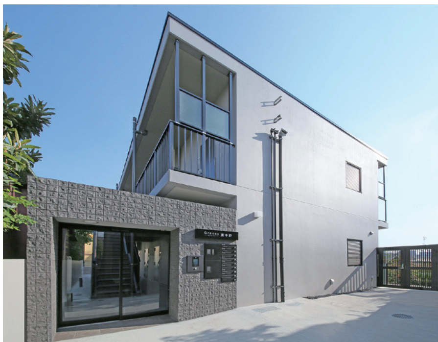
2024年に設計BIM→施工BIMの流れで取り組んだRC造2階建物(竣工)
